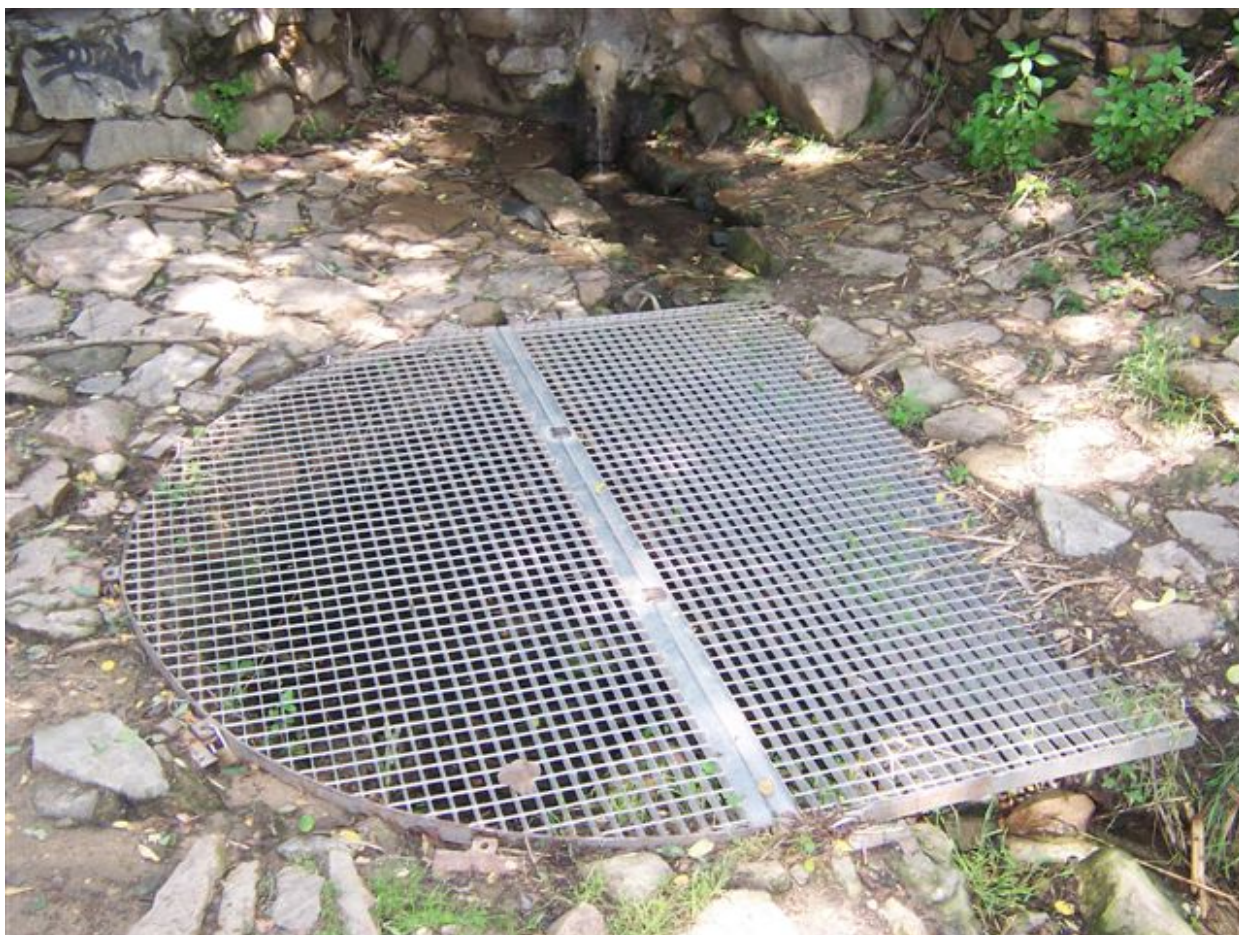
En primer pla aspecte de la nova basseta de la font de l'Amigó recoberta amb una reixa protectora i en segon terme la mateixa font. Fotografia feta el 7 de gener de 2003.
