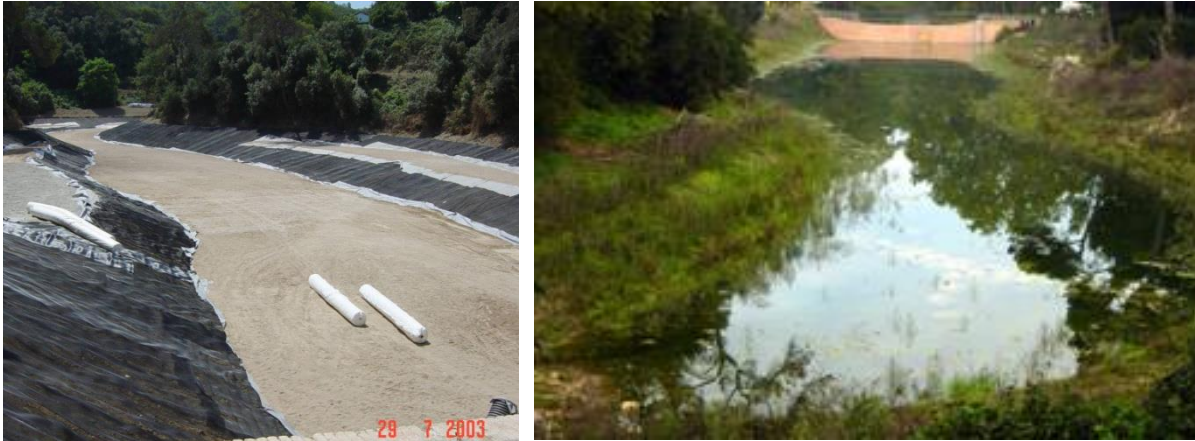
Vallvidrera en fase de rehabilitació (esquerra) i un cop recuperat (dreta).
